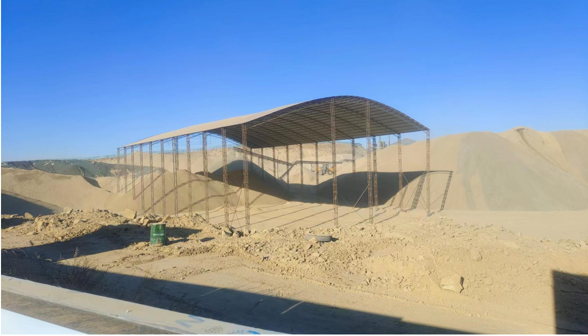
照片 5 堆料厂房及料堆
