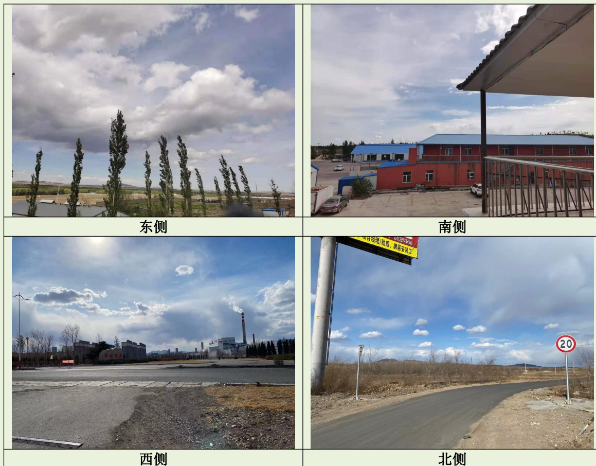
图 2.1-1 本项目厂区四周现状图片
